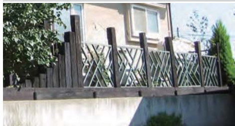
現代的金属材料と伝統素材の木材の組合せ
