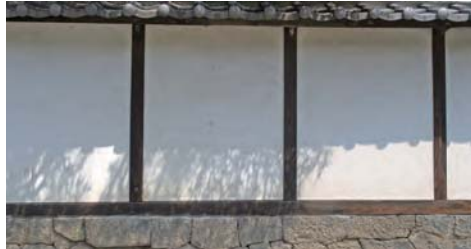
伝統的な瓦、漆喰、木、石の組合せ
