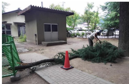
平成30年8月8日の折損事故
