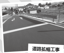
道路拡幅工事
