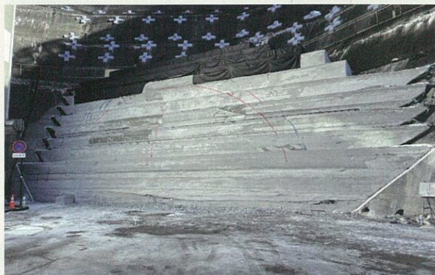
新入山隧道エアモルタル工事 施工状況
