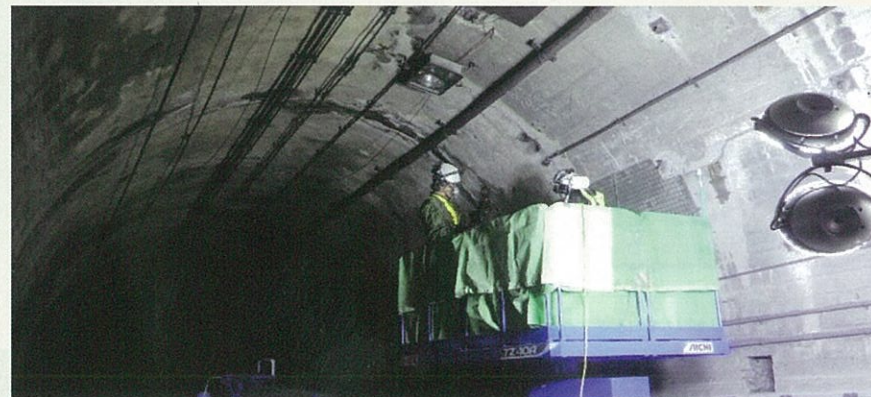
新入山隧道補強工事 (新入山トンネル掘削のための準備工) 施工状況
