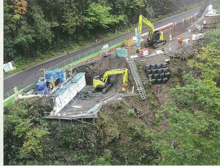
②下部工施工状況 (上高地側)
