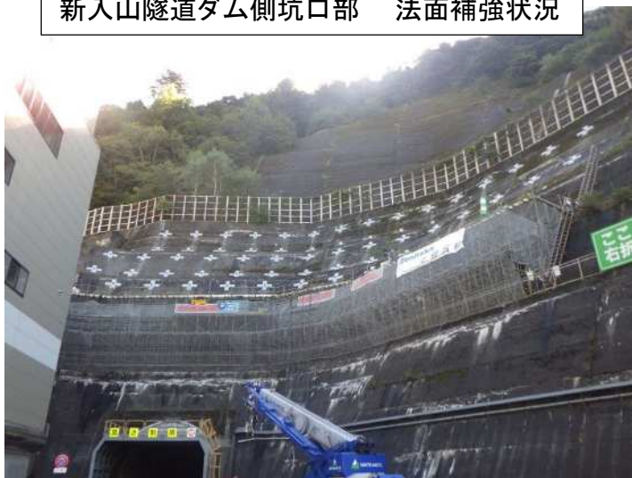
新入山隧道ダム側坑口部 法面補強状況
