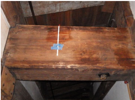
写真4 【天守】5階繫梁(南入側東から第4柱筋)
