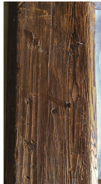
写真7 松本城天守5階 柱 台鉋痕
