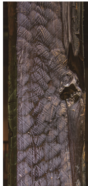
写真6 松本城天守 1階柱 鉦痕(蛤刃)
