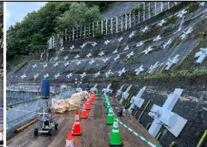
グラウンドアンカー設置状況
