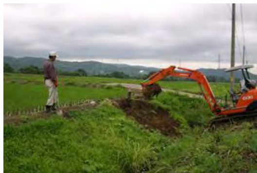
農用地法面の補修
