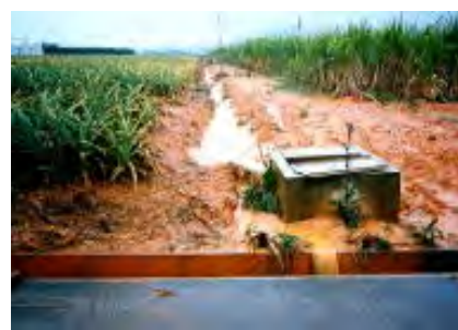
土砂の流出状況
