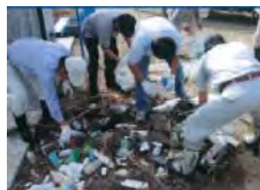
ゴミ・土砂の除去状況
