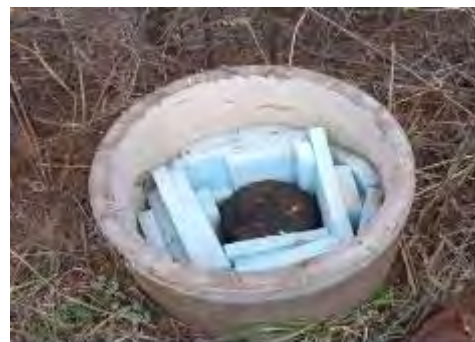
給水栓ボックス内の保温状況
