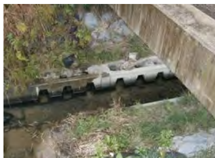
多孔コンクリート護岸
