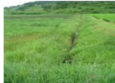
雑草の繁茂状況
