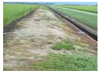
景観悪化の状況
