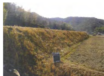
高低差のある畦畔法面
