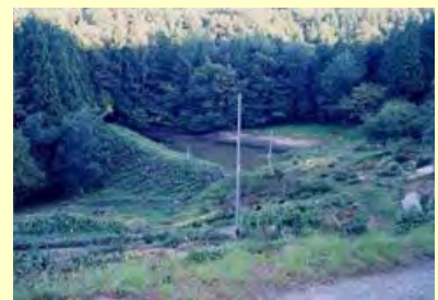
改修前のため池の様子
