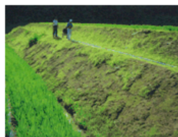
小段が設置されている法面
