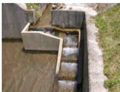
段差解消水路
