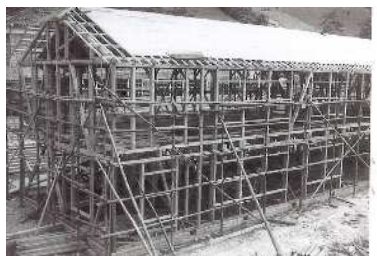
昭和28年5月第三校舎建て方工事
