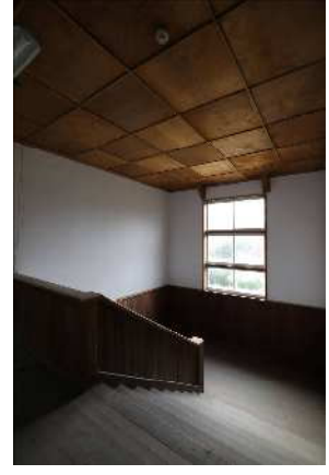
2階より踊場を見る
