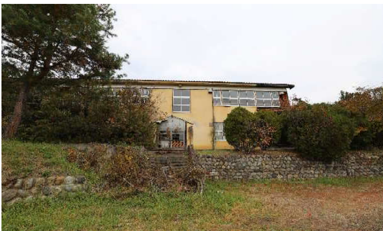
南面渡廊下接続部
