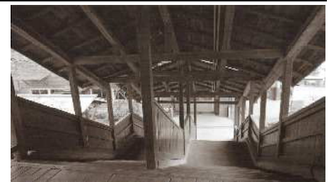
右：階段状の渡廊下⑱ 出典「木造校舎」
