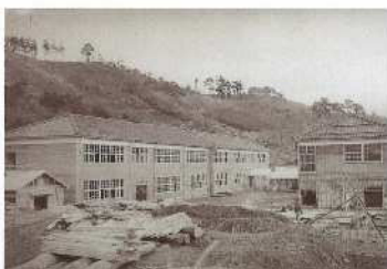
昭和28年4月第一校舎完成 工事写真4枚 出典「木造校舎」
