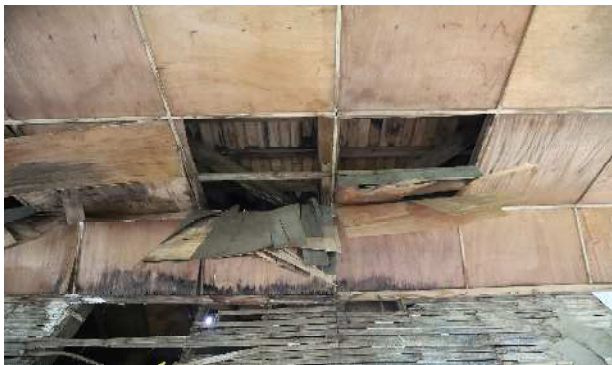
1階より2階床下を見る
