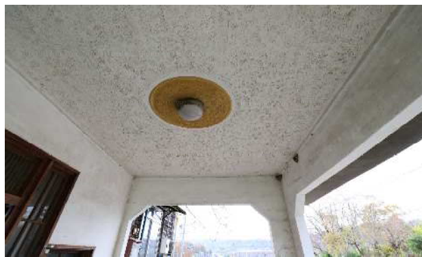
玄関ポーチ天井
