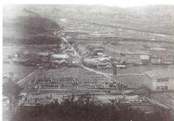
昭和27年12月基礎工事
