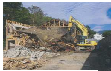
平成28年解体報告書より
