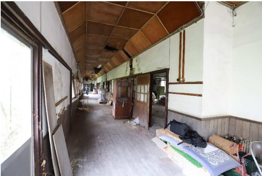
4.第三校舎内観(廊下東面)
