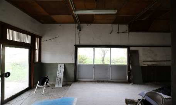
玄関ホール北第二校舎への渡廊下出入口
