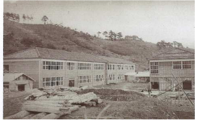
昭和28年第一校舎完成 出典「木造校舎」
