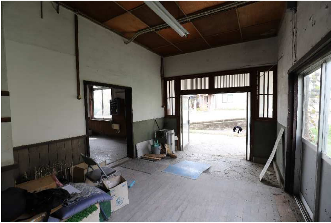
3.第三校舎玄関内観(職員玄関西面)
