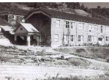
昭和29年10月完成 工事写真2枚 出典「木造校舎」
