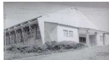
右：外観 出典「木造校舎」
