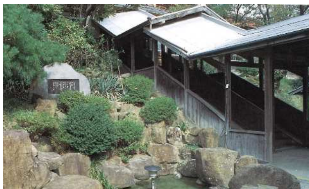
玄関ポーチ脇渡廊下
