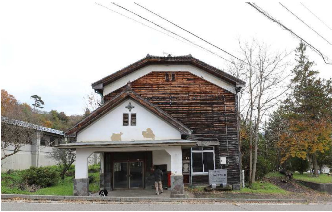
1.旧会田中学校第三校舎外観正面(西面) 令和6年(2024)11月
