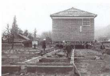
昭和27年12月第二校舎曳家工事
