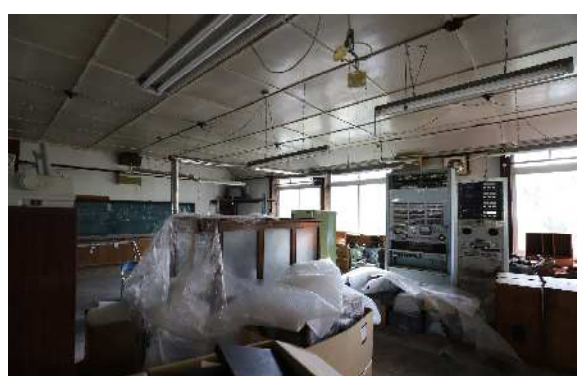
職員室南東面
