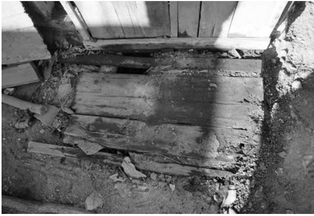
便所 既存便槽蓋
