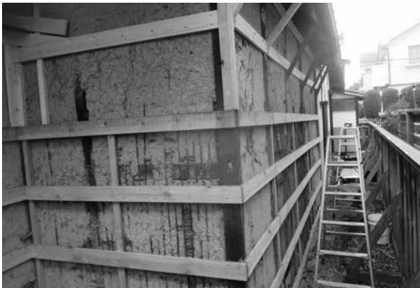
北土壁 木部補強及び仮設鉄板下地施工
