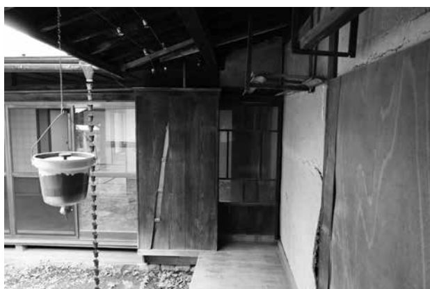
主家 東面、外廊下
