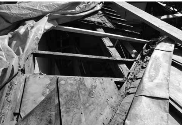
土居葺き野地板 腐食部撤去
