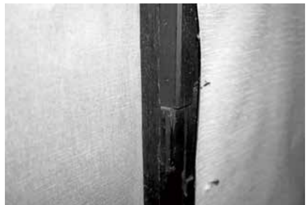
鷺見家住宅 二階の柱の継ぎ足し
