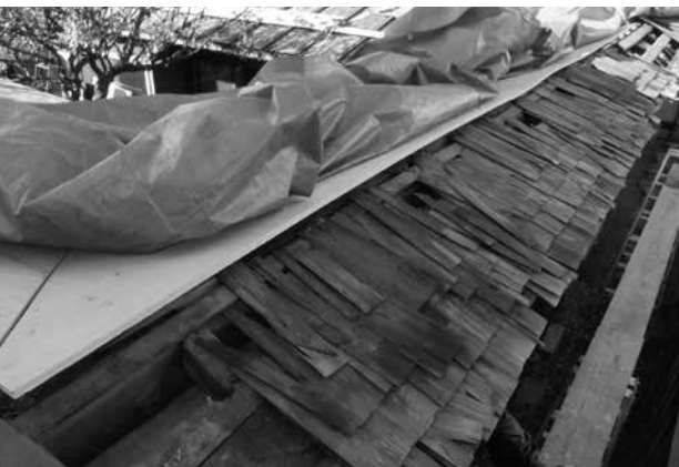
外廊下 屋根北側
