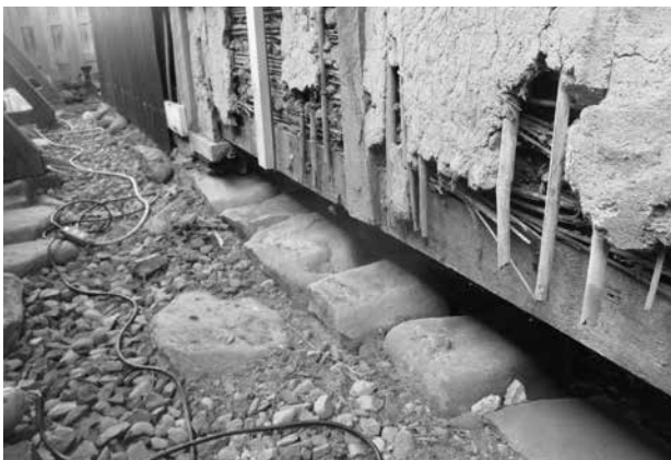
土台 腐食部撤去
