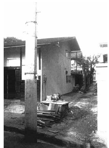
橋倉家住宅外観（改修工事後）
