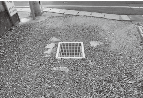
辻井戸 崩落防止対策
