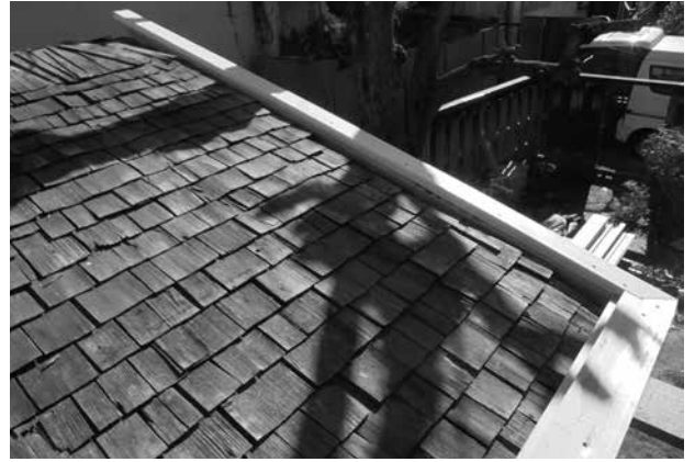
土居葺き 残存部分
