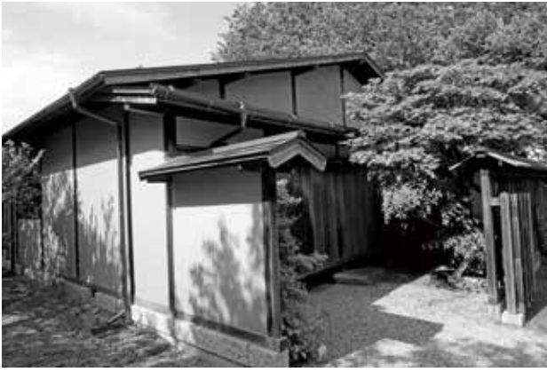
木下家住宅 外観
