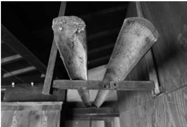
過去に使用した木製軒樋
