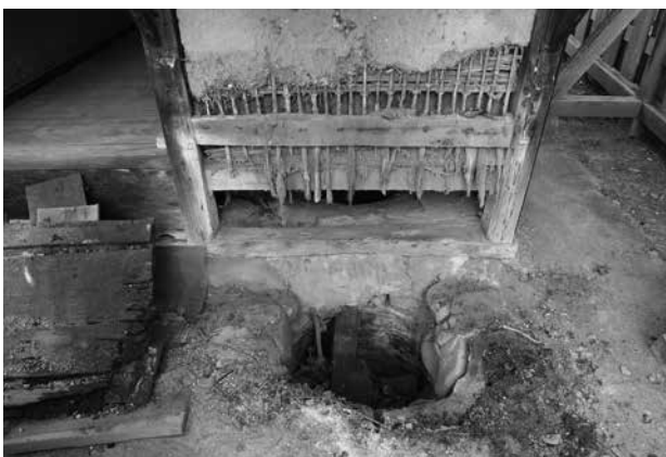
便所 便槽部・南壁面木部解体
