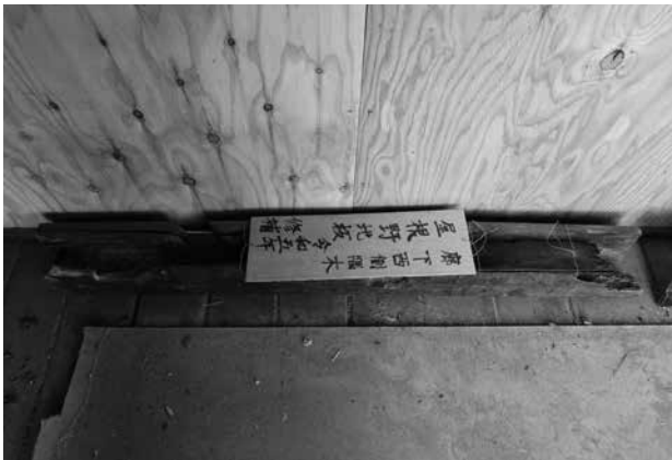
令和5年度 解体材 廊下西側隅木、屋根野地板
