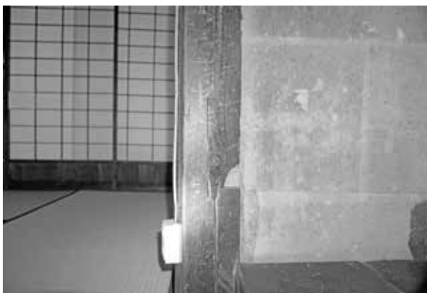
柱の根継ぎ（なかのま押入）
