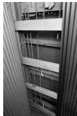
外廊下北側外壁状況
