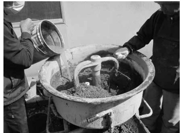
土混ぜ合わせ作業状況
