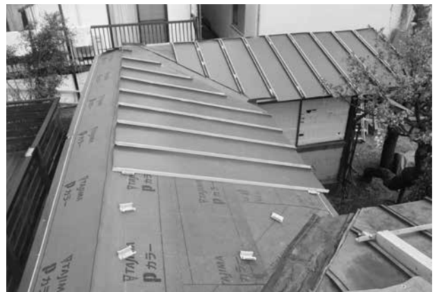
鉄板葺き施工
