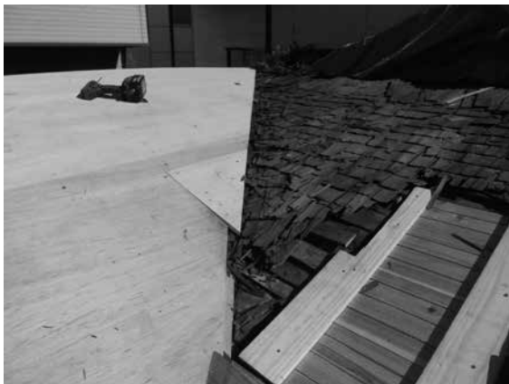
合板補強、既存土居葺きと欠損部分補強状況
