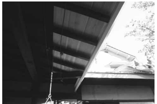
野地板 鼻隠し補修
