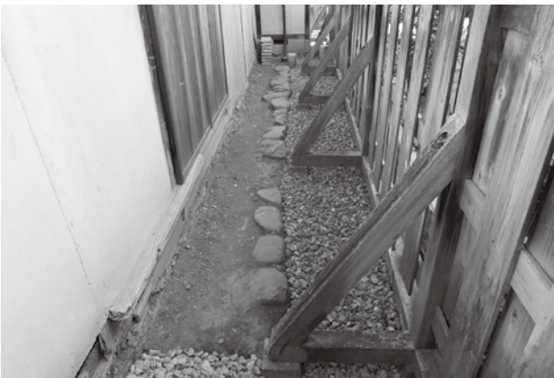
北側 土すき取り、碎石敷き
