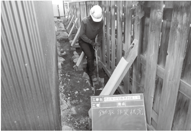
北側 土すき取り
