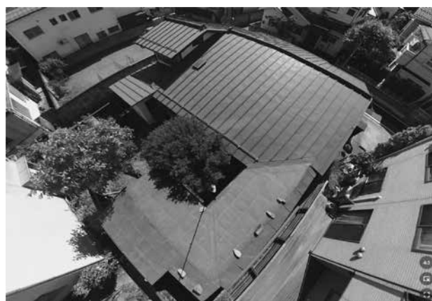
便所・外廊下・主家 屋根
