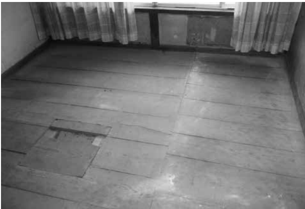
二階 畳撤去状況
