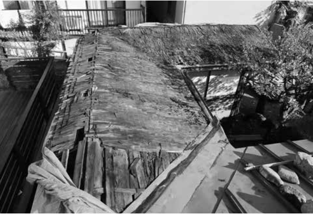
鉄板葺屋根 解体状況
