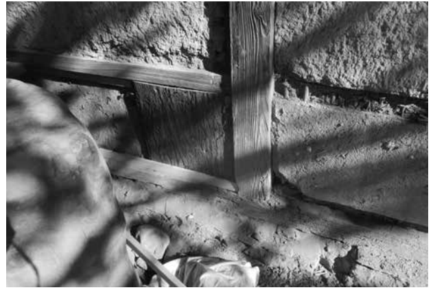
便所 杉皮張り施工
