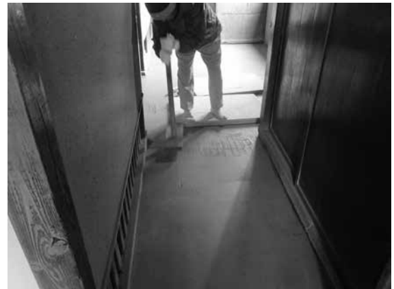
土間たたき仕上げ作業状況
