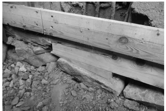
土台 木部補修
