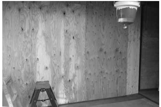
外廊下 南土壁部合板補強
