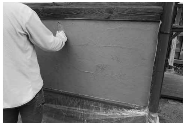
便所 土壁補修
