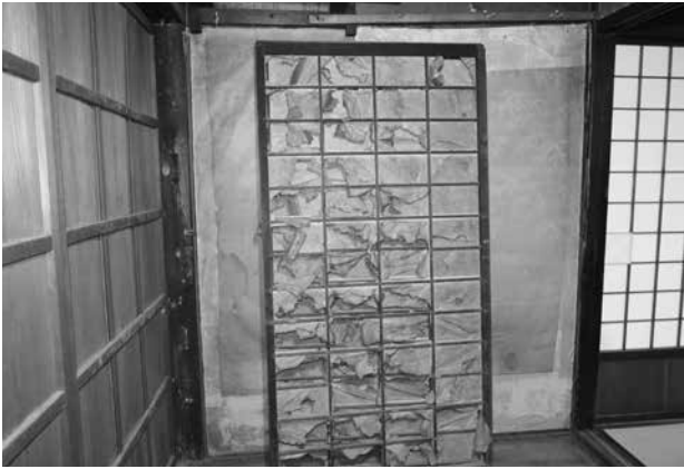
しもざしき裏の納戸 既存建具
