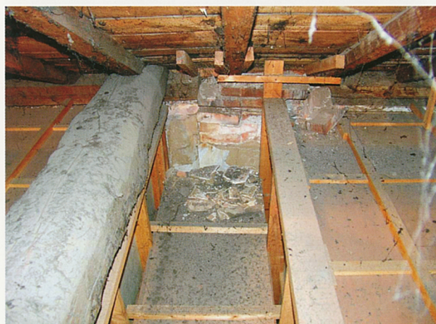
南壁煙突除去部分の小屋裏
