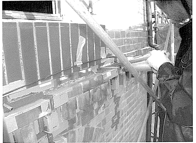
写真16 ひび割れの補修作業
