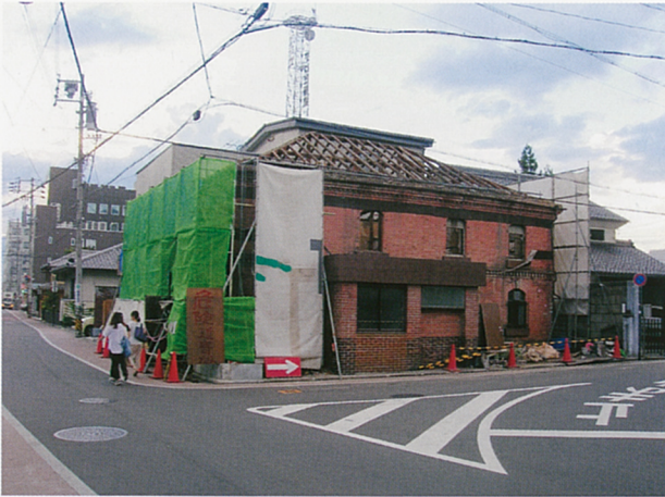
屋根の除去作業
