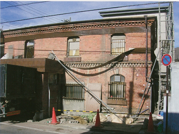
東面北側（1階窓のアーチ部分に木柱が残る）
