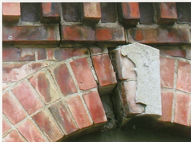
1階南面東側アーチ部の要石（煉瓦を砂漆喰で被覆）
