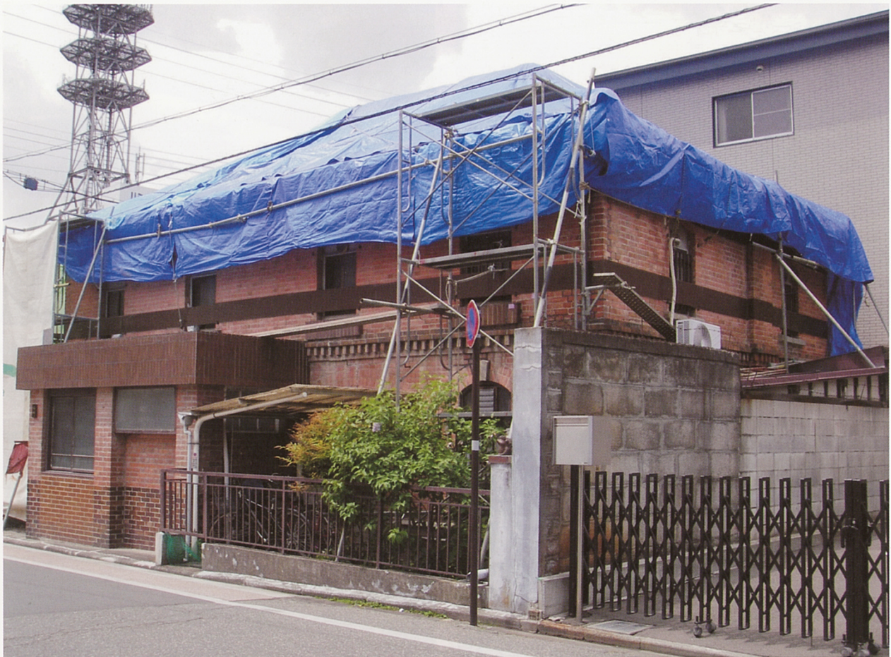
倒壊防止のため2階の煉瓦壁外面を炭素繊維のシートで鉢巻状に固定
