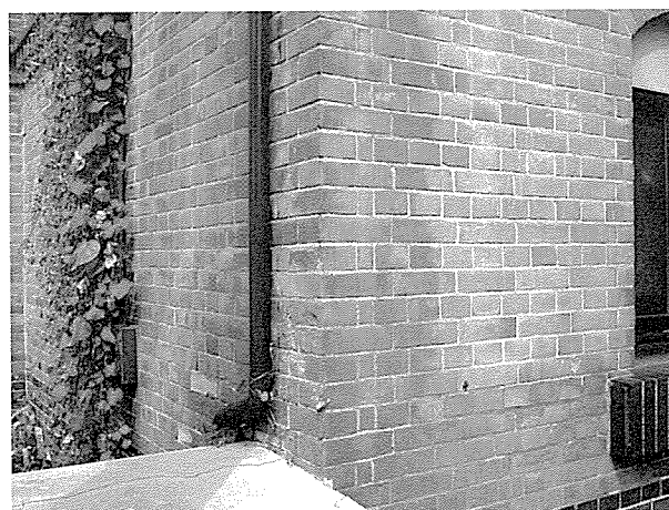
写真13 解体前の南東角(2003年9月)
