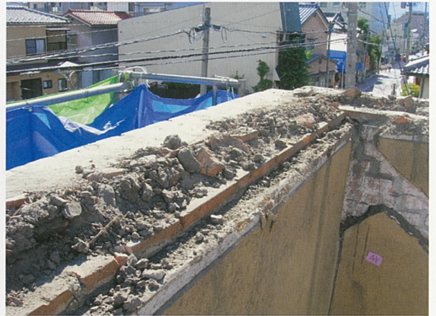
砂漆喰で固められた煉瓦壁最上の屋根との接合部
