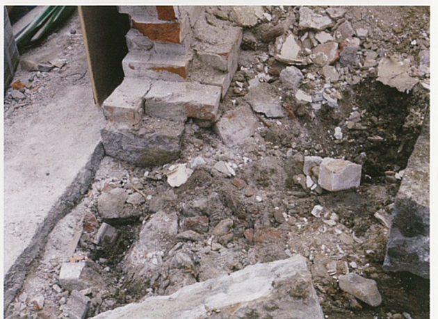
東壁面の延石基礎（西側の一部は間知石基礎）
