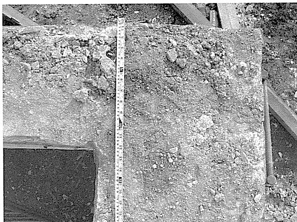
写真12 旧三田尻塩務局長浜出張所煉瓦倉庫の直交壁断面
