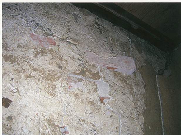
2階北西和室の北面アーチ上の煉瓦の突出
