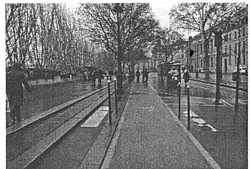
車道に設置した自転車専用レーン
